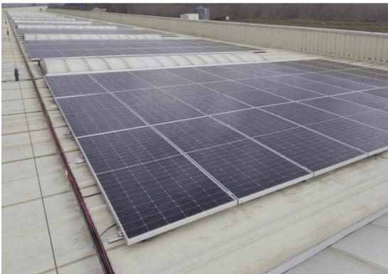
Imagen 2. Placas solares instaladas sobre la fábrica de Baños II para la generación de energía renovable
