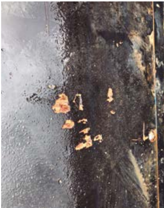
Golpe de vibrador en la cara del tablero.
